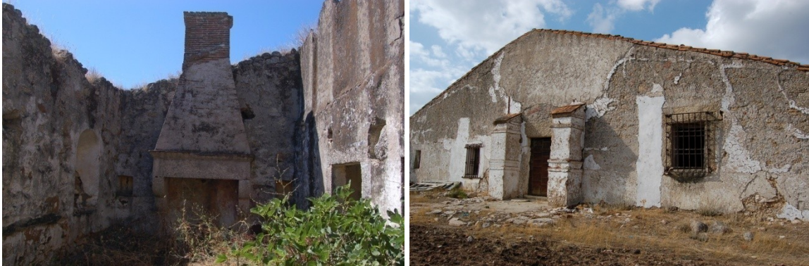
Foto n.º 31: Casa de los Roeles, con bóvedas de aristas y potente chimenea con soportes en piedra.
