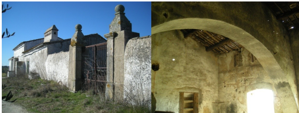
Fotos n.º 29-30: Casa de las Clementas. Exterior y detalle del lagar.
