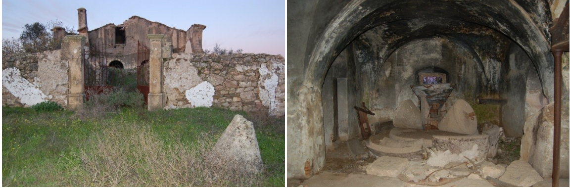
Fotos n.º 23-24: Lagar de Perero, entrada a las cuadras y molino de bajo bóvedas de arista.
