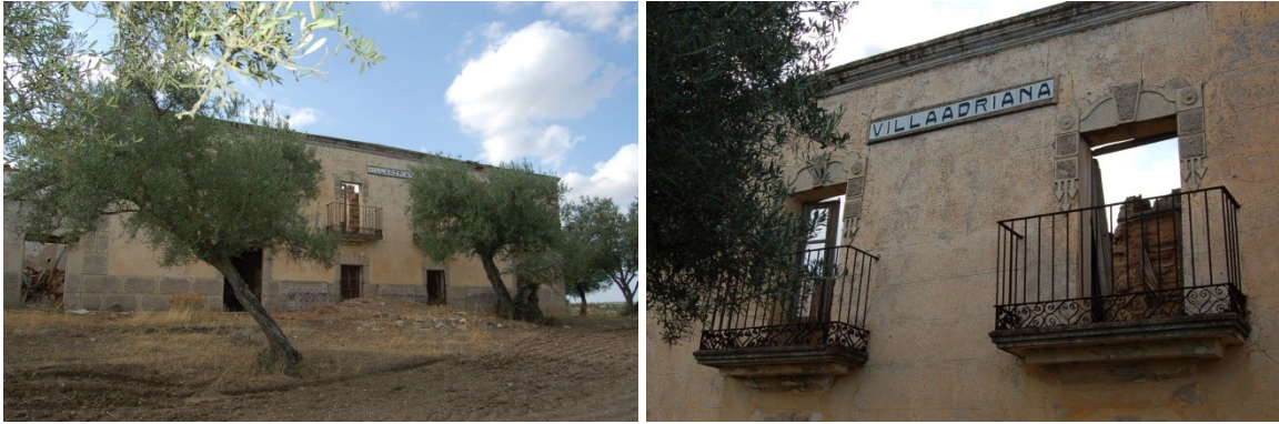
Fotos n.º 37- 38: Villa Adriana- Finca de los Pilonos. Fachada principal y detalle de vanos y balcones.
